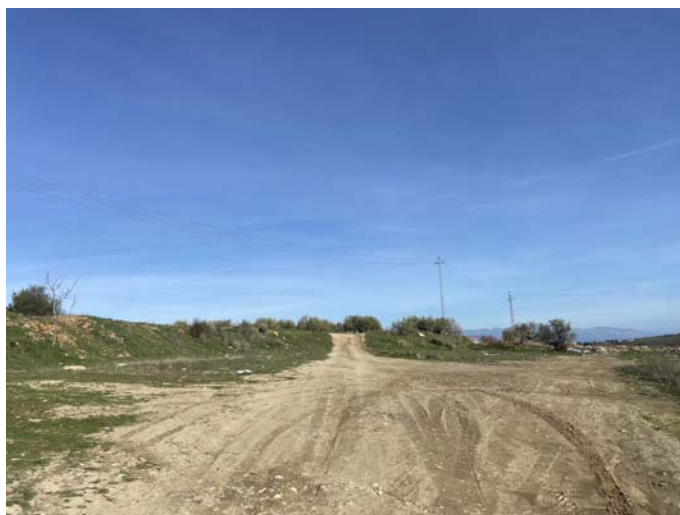
Línea de media tensión que discurre el polígono de oeste a este.
