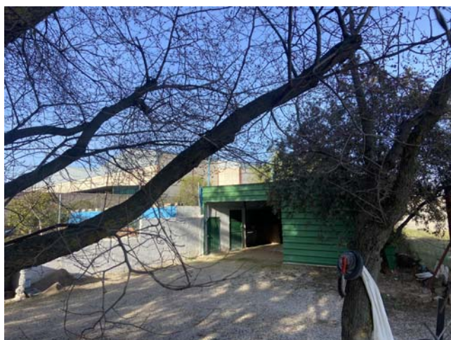
Construcción en precario existente al norte del sector.
